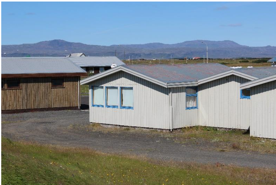
Færanlegar kennslustofur á Eyrarbakka
